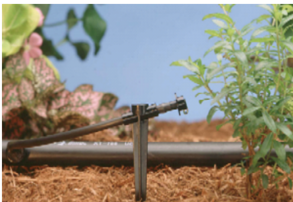
Figura 13 – Detalhe de Instalação de Gotejador em vasos em uma parede verde.
